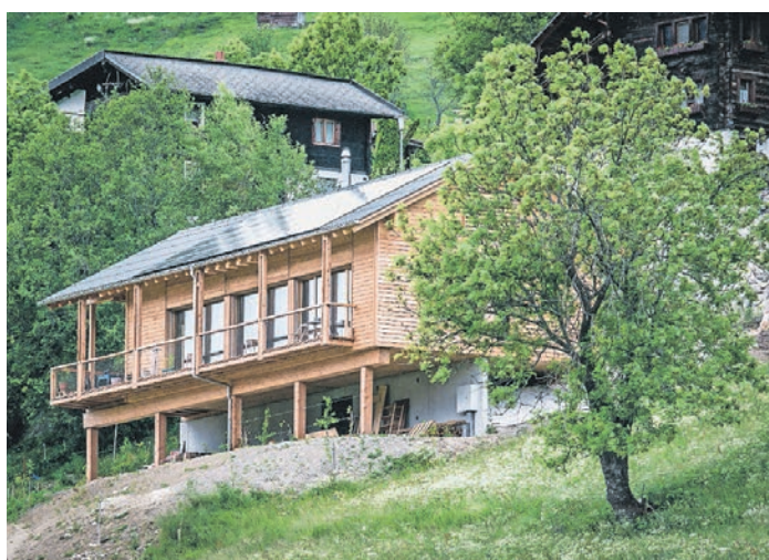
Energieproduzenten. Ein zentrales Element des solaren Direktgewinnhauses ist die Fotovoltaikanlage auf dem Dach.
